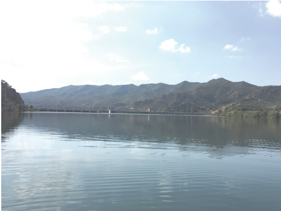
Figura 7. Vista de la presa del embalse
