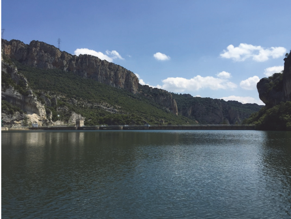
Figura 6. Vista de la presa del embalse.
