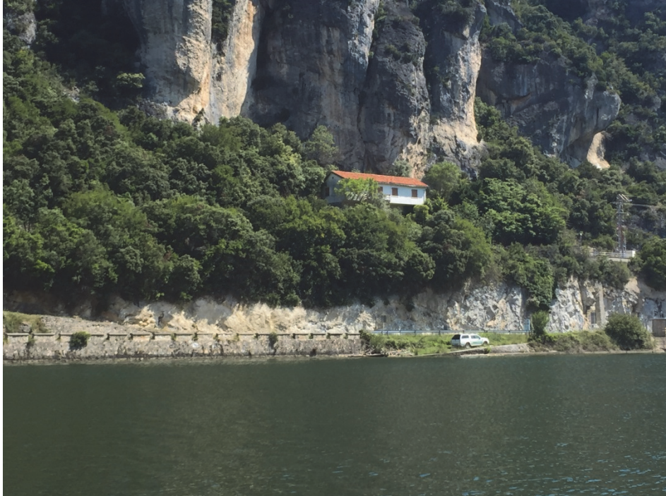
Figura 7. Vista del punto de acceso al embalse.
