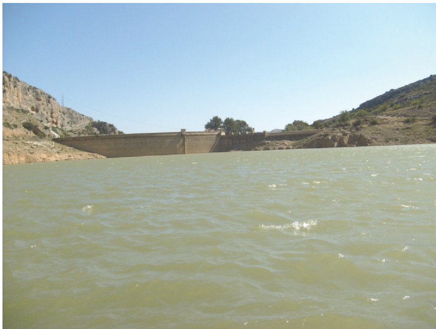
Foto 1: Vista de la presa del embalse
