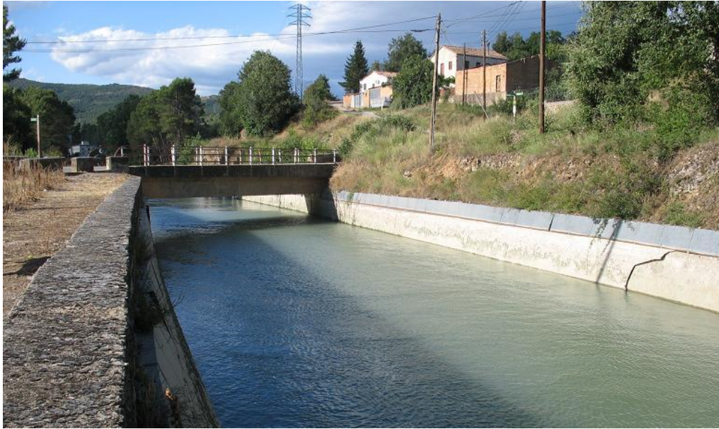
Figura 10-13. Canal de derivación en las inmediaciones de Tremp.
