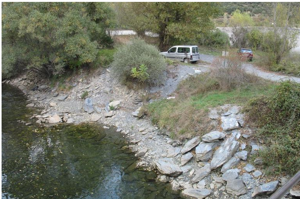
Figura 10-7. Escombros en las márgenes del río en las inmediaciones de la localidad de Aídi.
