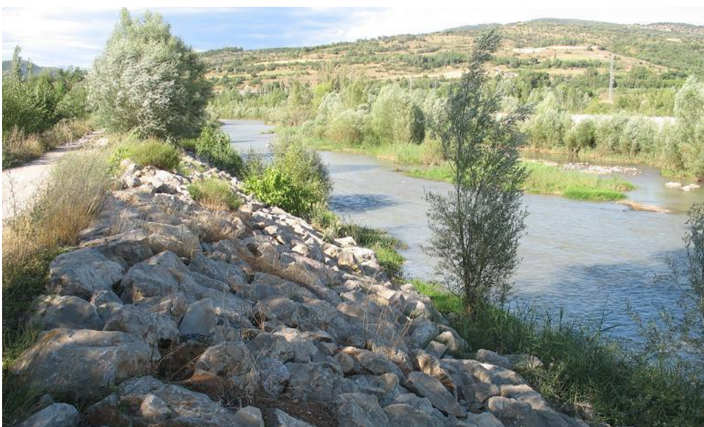
Figura 10-14. Defensas laterales en la parte baja de la masa de agua.
