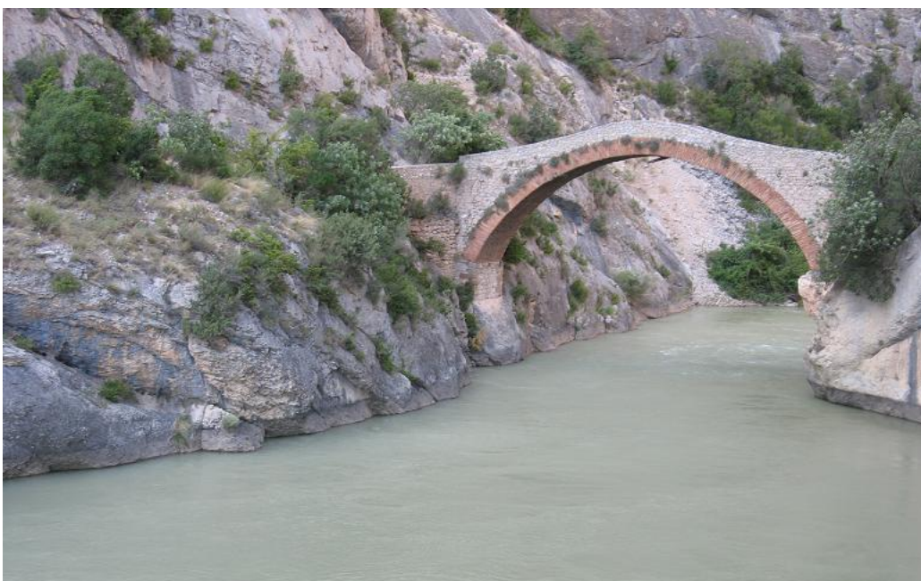
Figura 10-18. Puente a escasos metros de la cola del embalse de Camarasa.
