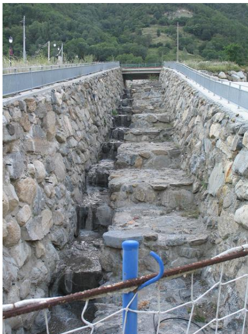
Figura 10-30. Canalización de un afluente del río Flamisell.
