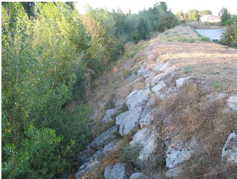
Figura 1-7. Escollera lateral en el río Nela.
