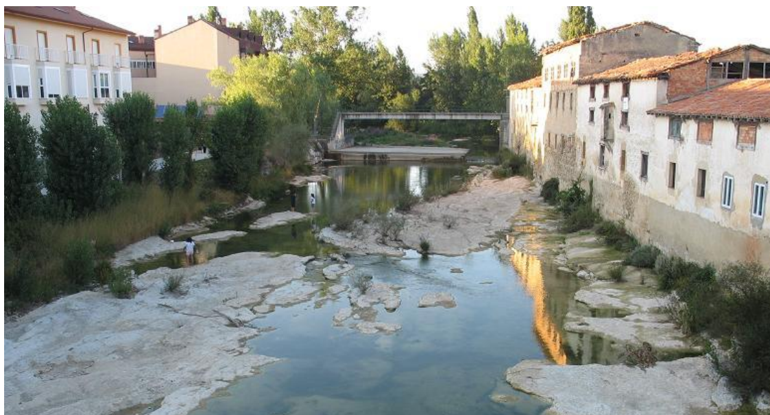
Figura 1-18. Cauce del río Trueba en la localidad de Medina de Pomar.
