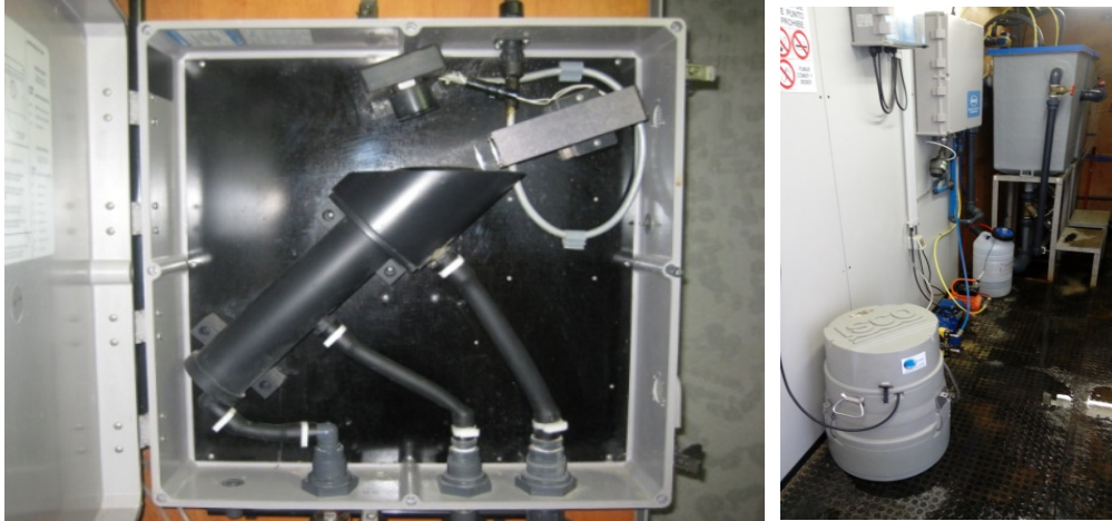
Figura 10. Turbidímetro Hach SS6 ® la estación de calidad de aguas de Monzón (Izquierda) y, ISCO ® 3700 instalado de manera permanente dentro de la misma estación (Derecha).
