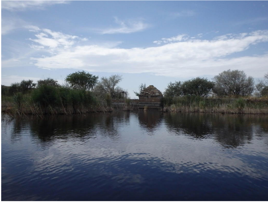
Infraestructuras en la cubeta
