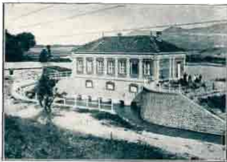
CANAL DE LOGROÑO. CASA DE CONFERTAS
